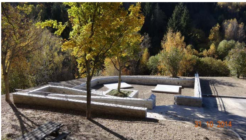
Aire de Repose et de Chaînage de Pont de Bou
