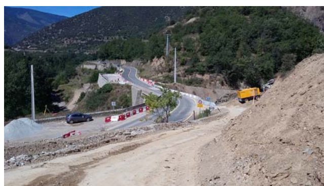
Travaux en cours
